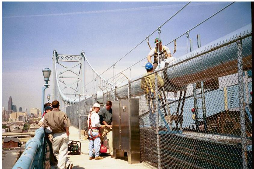
写真1 ケーブル上へのAEセンサーの取り付け状況
